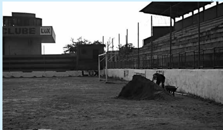
O Estádio Renatão, da Raposa, está recebendo diversas melhorias
